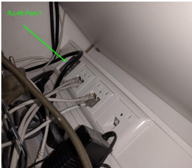
Das Anschlusspanel im Kassenbereich, an dem der Netzwerkport 1 herauskommt sieht so aus. Eine der Steckdosen müsste per Verteiler noch für den PoE-Injector zugänglich gemacht. Alternativ schliessen wir diesen auch noch im Bereich der Fritzbox an.
