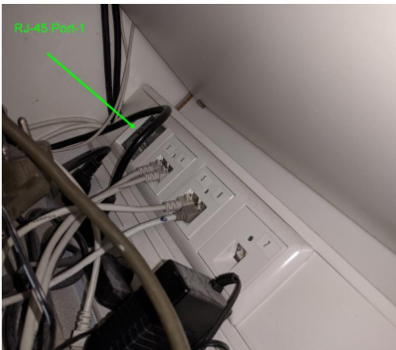
Das Anschlusspanel im Kassenbereich, an dem der Netzwerkport 1 herauskommt sieht so aus. Eine der Steckdosen müsste per Verteiler noch für den PoE-Injector zugänglich gemacht. Alternativ schliessen wir diesen auch noch im Bereich der Fritzbox an.
